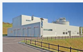
稚内市バイオエネルギーセンター
