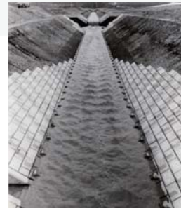
改修工事が進んだ駒生川
